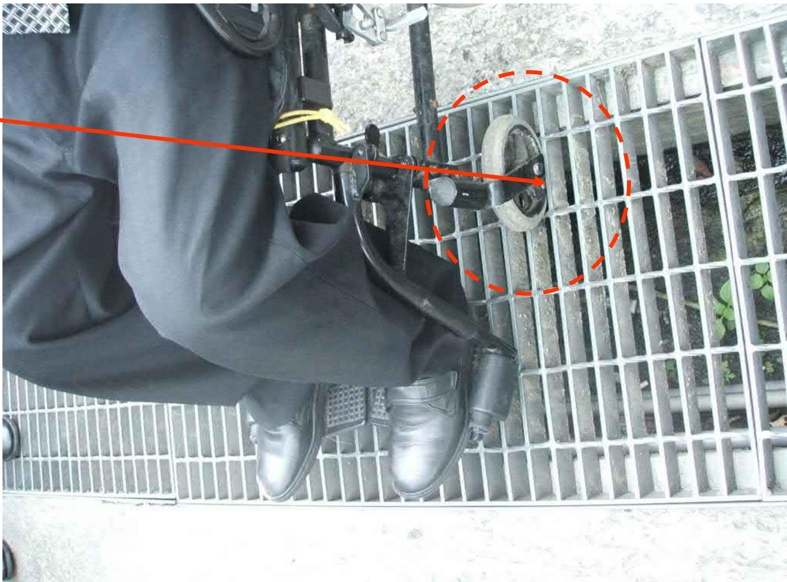
水溝柵欄空隙太寬輪椅前輪會卡入縫隙裡，縫隙應低於<sup>1</sup>/<sub>3</sub>公分，柵欄方向得調整為與行進垂直。
