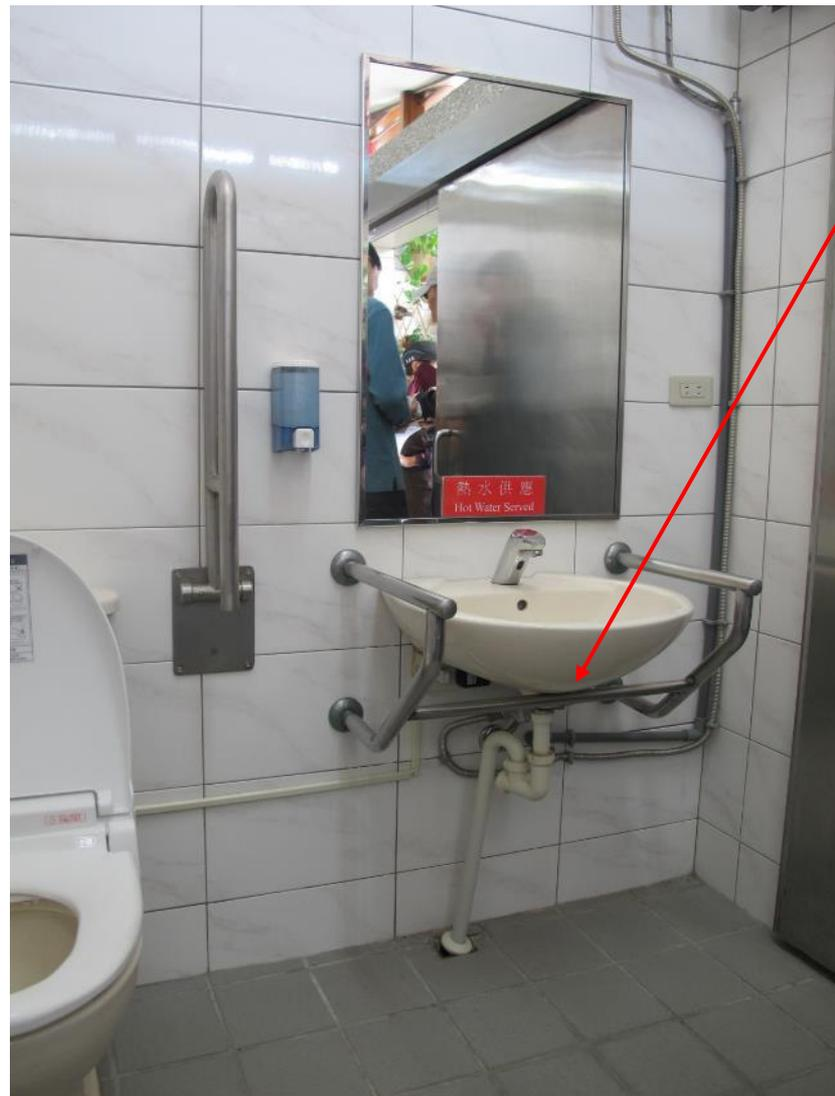
壁掛式洗面盆已於下方加設安全支撐加設者。
