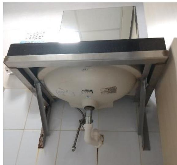
設置檯面式洗面盆或設置壁掛式洗面盆已於下方加設安全支撐加設者，得免於兩側及前方設置環繞洗面盆之扶手。
