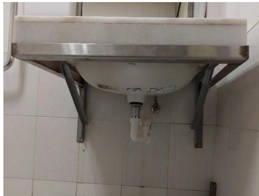
壁掛式洗面盆已於下方加設安全支撐加設者。
